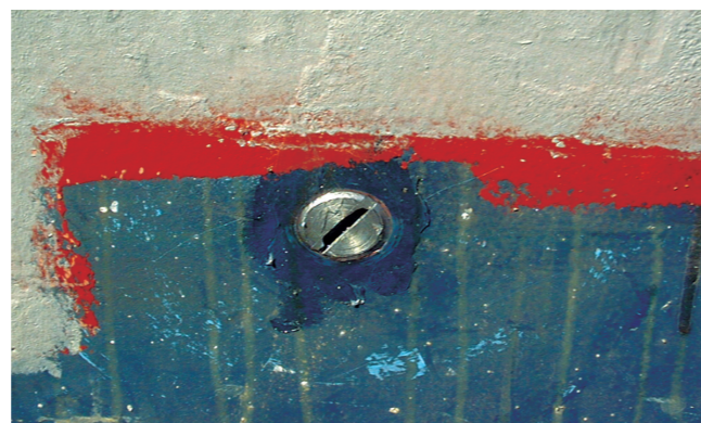
Figura 6: aspecto de uno de los puntos de dosificación tras acabado el trabajo
