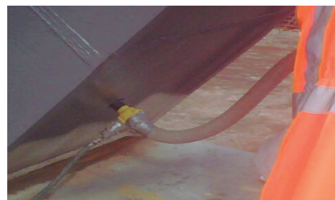
Figura 5: momento de la aplicación del inhibidor de la corrosión a través del punto de acceso abierto, en este caso, en un puente metálico
