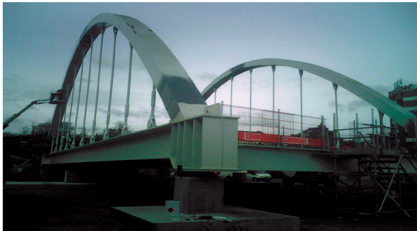
Figura 1: ejemplo de estructura metálica con dificultad de acceso interno
